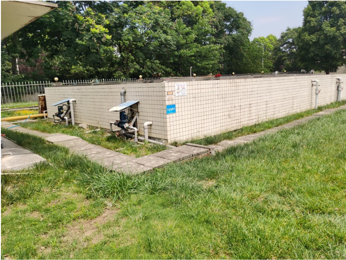
图 4-5 污水处理厂隐患排查
